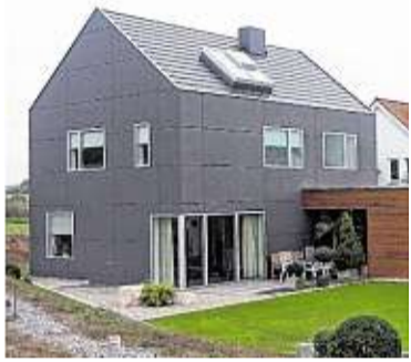
Das „schwarze Haus“ in Helmstadt ist mit Faserzementplatten verkleidet. FOTO: CHRISTIAN SCHULZ
